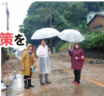
2018年西日本豪雨災害 北九州市内のがけ崩れ箇所を調査
